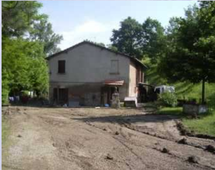
Esondazione del Rio d'Orzo con allagamento di un'abitazione privata
