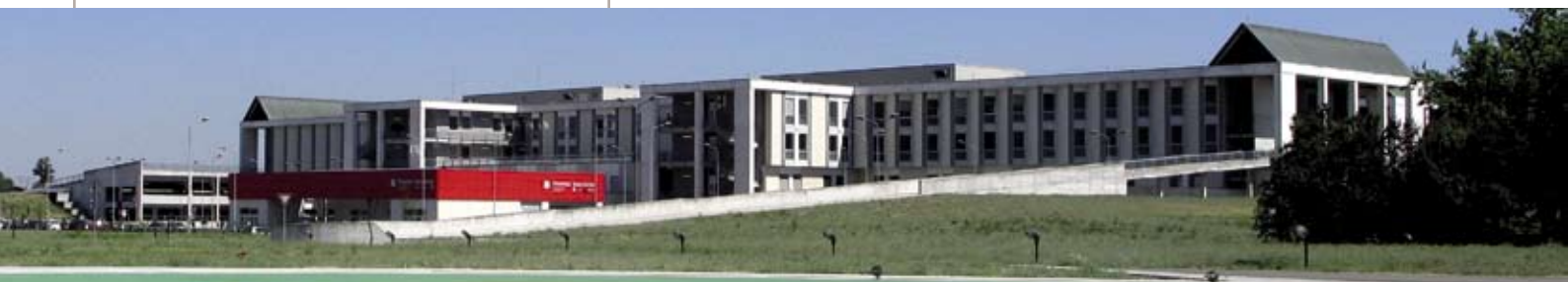
Nuovo Ospedale Civile / New Civic Hospital - Baggiovara (Mo).
