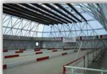
Impianto per il gioco della BOCCE
